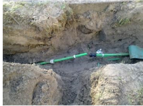
Figuur 3.6: Kabels en leidingen in Utrecht (foto L. Maring)
