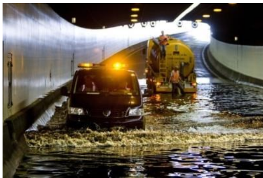
Figuur 3.7: Wateroverlast Botlektunnel Nederland (foto: Deltares)
