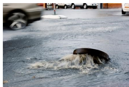
Foto 3: Overstroming riool (foto: gemeente Appingendam)
